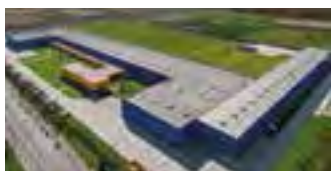
Hörmann Tianjin, Kína
