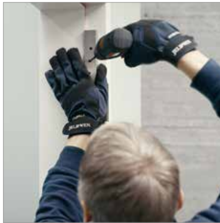
Schrägverschraubung mit Bohrschablone
