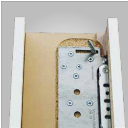
Schrägverschraubung im Zargenfalz
